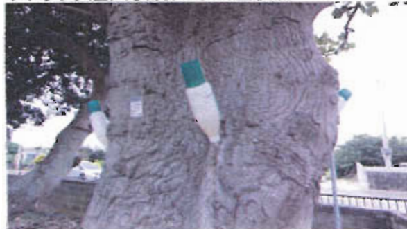
アトラック注入状況又は加圧状況
