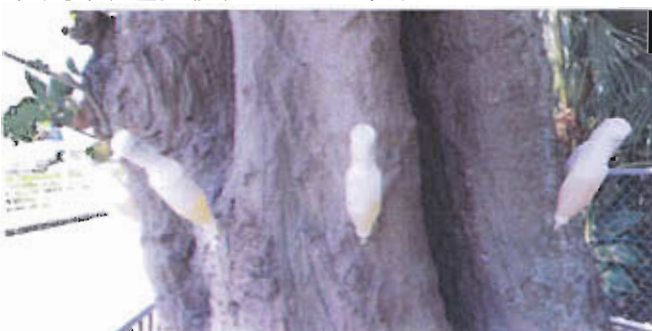
アトラック注入状況又は加圧状況
